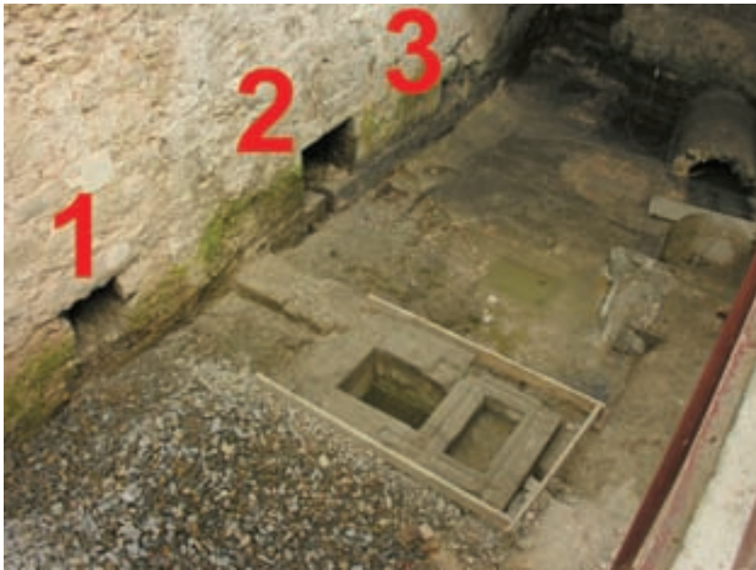
Detalle del plano de 1678 en el que se ve el departamento de herrería con sus tres ruedas hidráulicas -rueda del torno (1), rueda del mazo (2), y rueda del fuelle (3)-, así como la fragua (4) y la carbonera (5), y fotografía de los agujeros de los ejes de las mismas ruedas, y el asentamiento del mazo, en la obra de rehabilitación.
